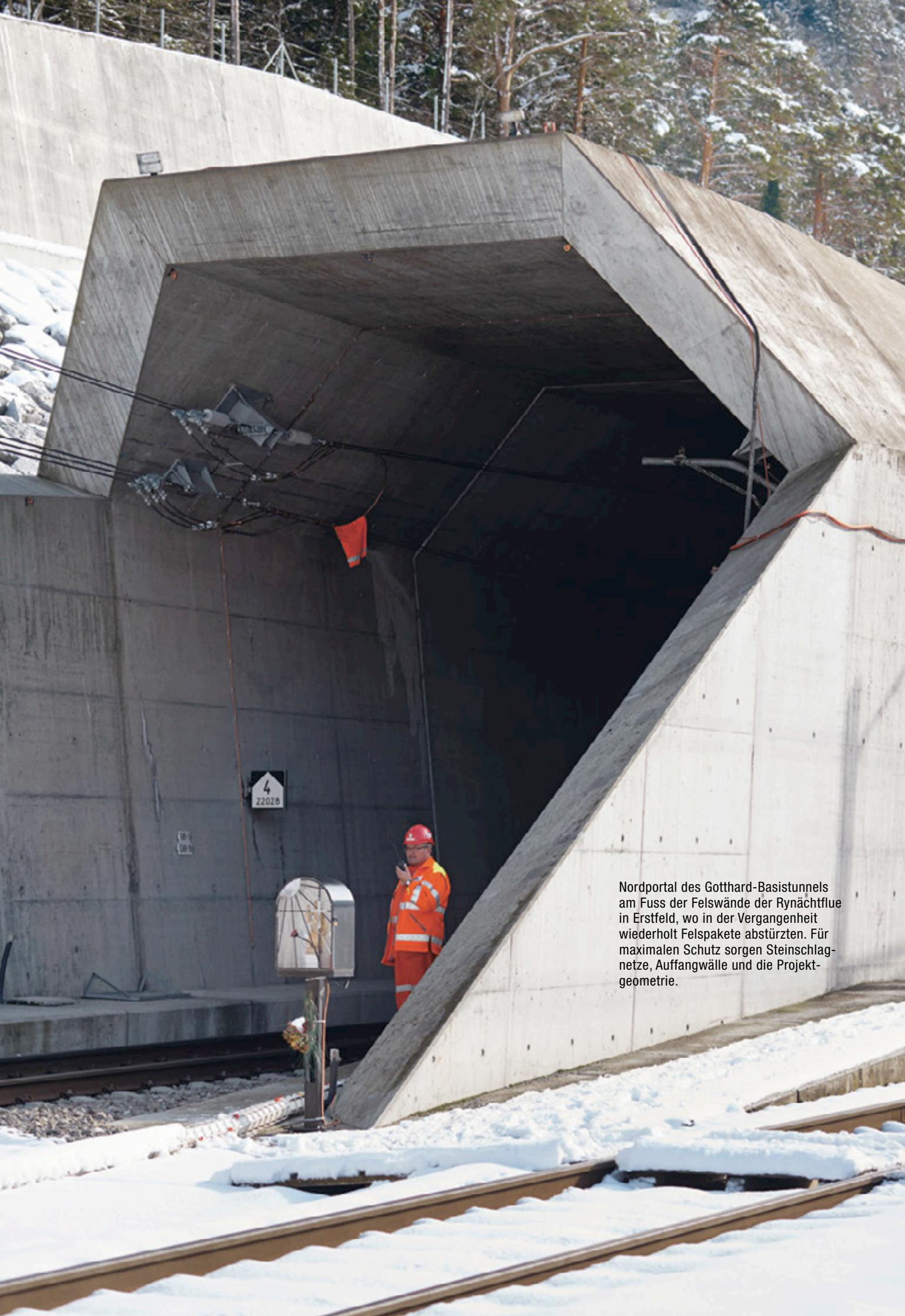
Nordportal des Gotthard-Basistunnels am Fuss der Felswände der Rynächtflue in Erstfeld, wo in der Vergangenheit wiederholt Felspakete abstürzten. Für maximalen Schutz sorgen Steinschlagnetze, Auffangwälle und die Projektgeometrie.
